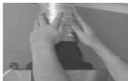
7. Подключите одну часть алюминиевой трубы к вытяжке через адаптер, другую часть трубы выведите в вентиляцию.
